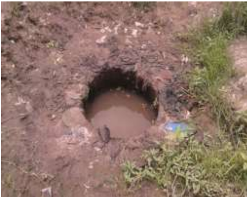
Photo 1 : Exemple d'un puits à buse
